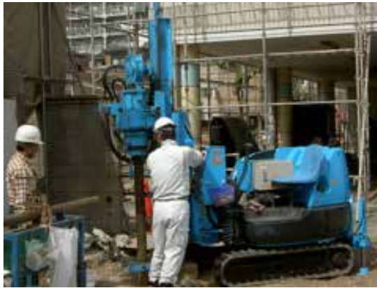
土壤汚染用ボーリングマシン
